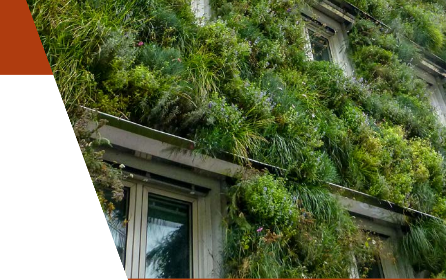
Einbau von Brandsperren über jeder Fensterreihe.
