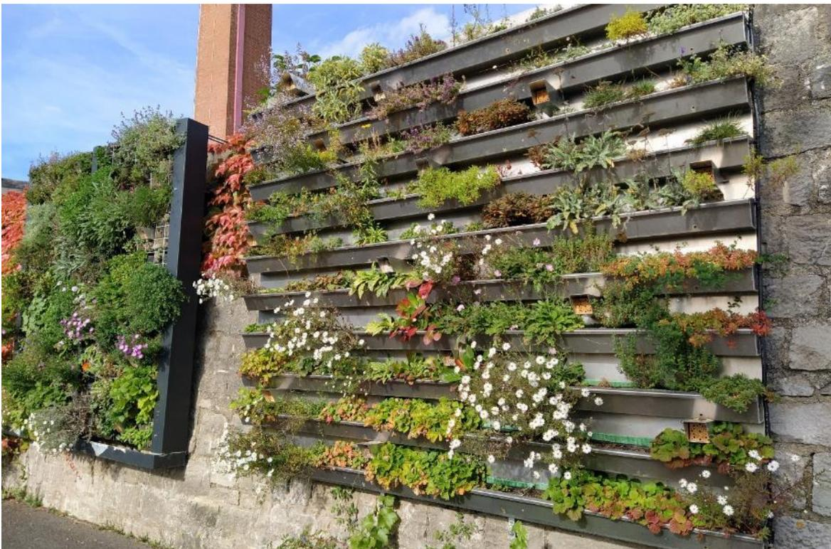
*Bild 2: Biodiversitätsfördernde Fassadenbegrünungen, links das Gabionensystem (Vertuss – Vertical Green, Uden, NL) und rechts das Rinnensystem (Tech Metall Erzeugungs- und Handel und Montage GmbH, Wien, Österreich).*
