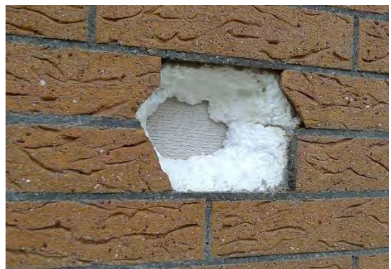
Bild 2: Vorsicht Falle! Aufgeklebte Klinkerfliesen auf Styropor-Untergrund.
