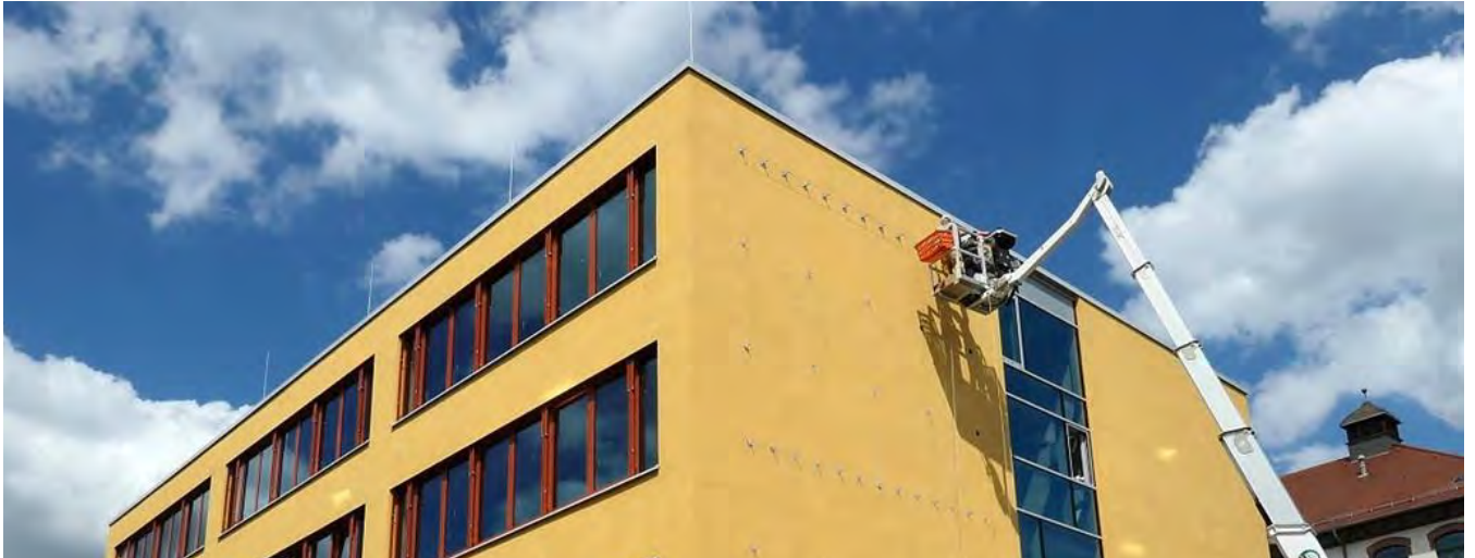
Bild 3: Montage von Seilhaltern XP 12XX7 für Dämmung, Kepler-Gymnasium Leipzig / Sachsen.
