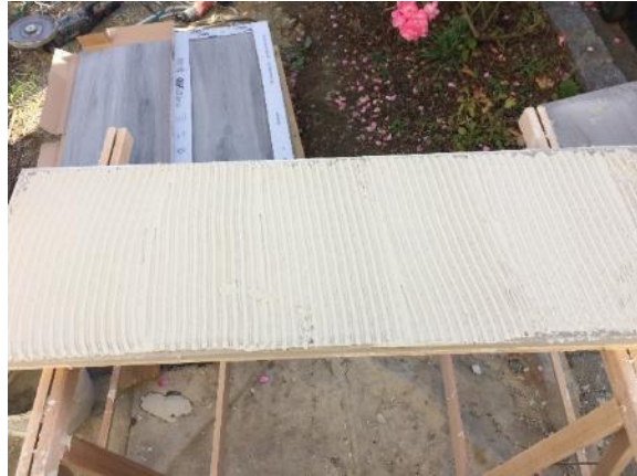
Bild 3: Mittels einer Zahnkelle wird die Haftschlämme aufgebracht.
