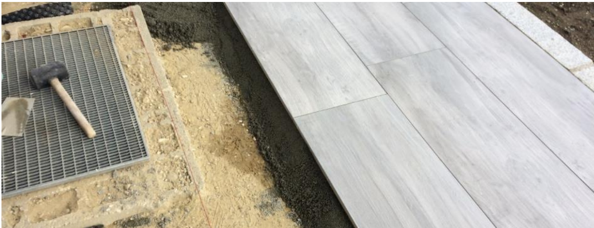
Bild 1: Bei dünn-schichtigen Keramikbelägen hat sich die gebundene Bauweise auf einer Bettung aus Drainmörtel durchgesetzt.
