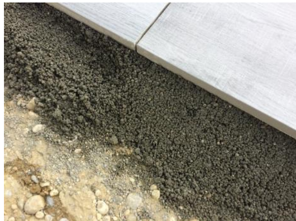
Bild 2: Der Einbau des Bettungsmörtels sollte homogen und zeitnah zur Verlegung der Platten erfolgen.
