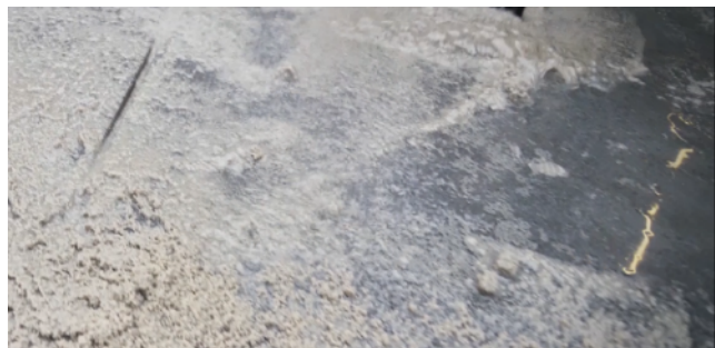
Bild 4: Der Fugenmörtel wird in fließfähiger Konsistenz mittels Gummischieber eingebracht und anschließend abgespült oder abgekehrt.
