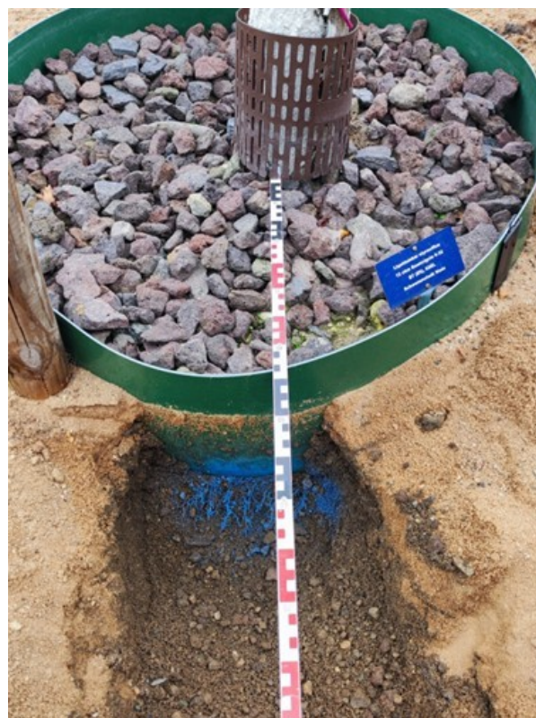
Bild 8: Auswurzelung Baum 7, Liquidambar styraciflua bis 30 cm, bei ausreichend guter Vitalität des Baumes.
