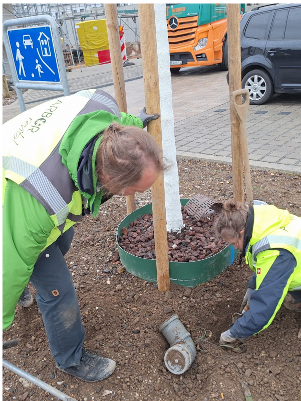
Bild 3: Setzen der Telemetrie-Einheit durch Alexander Borgmann gen. Brüser und Susann Wagner von der Firma Arbor revital.
