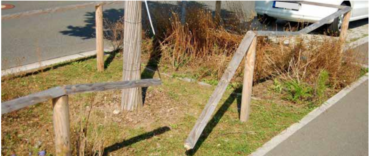
Bild 27: Zerbrochene Umzäunung an der Fläche mit gebietseigener Mischung im Abschnitt A. Die Halbrundbalken wurden regelmäßig ausgetauscht.
