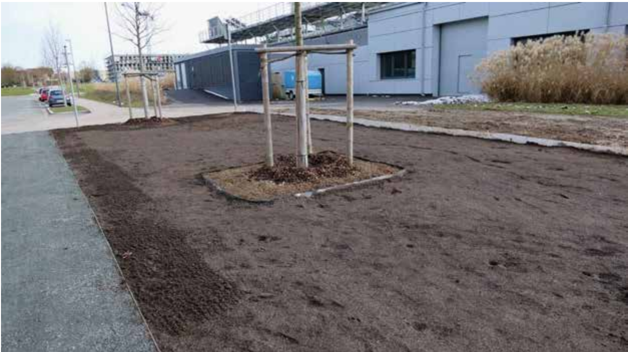
Bild 2: Mit Substrat aufgefüllte und zur Ansaat vorbereitete Untersuchungsfläche C1 am 18.02.2021. Um die Baumscheibe herum und an der hinteren Flächengrenze ist die Rhizomsperre sichtbar, welche die Ausbreitung der Sumpfkresse in die Untersuchungsfläche verhindern soll.
