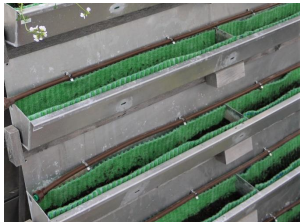
Bild 2: Leere Rinnen, die mit einem Vlies ausgelegt sind, über dem Tropfschläuche angebracht sind (April 2021).
