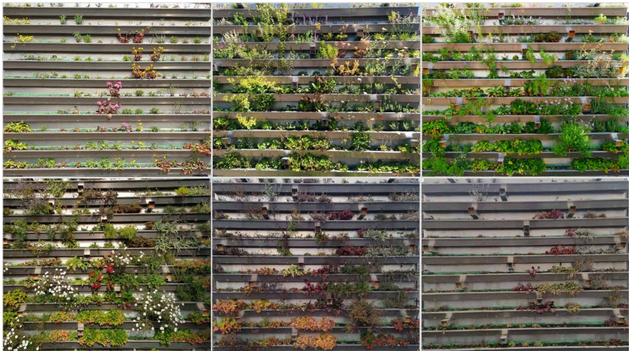
Bild 16: Rinnen an der LWG im Jahresverlauf. Von links oben nach rechts unten: April 22, Juni 22, August 22, Oktober 22, Dezember 22, Februar 23.
