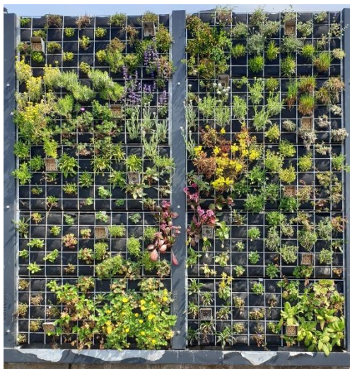
Bild 7: Gabionen an der Mensa der LWG. Zehn Gabionen sind zu einer Fassadenbegrünung zusammengesetzt (Mai 2022).
