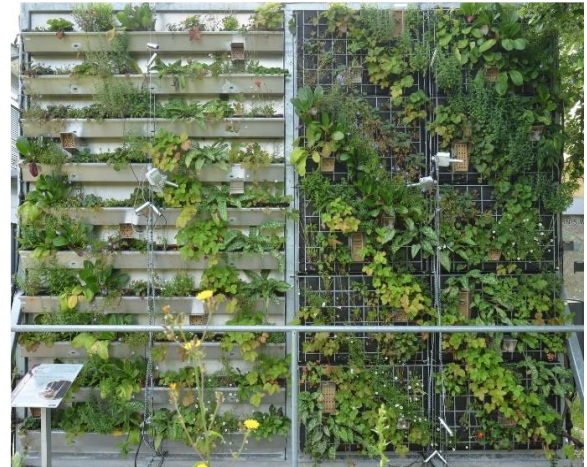
Bild 4: Westfassaden an der KFS, links zehn Rinnen und rechts zehn Gabionen (Juni 2021).
