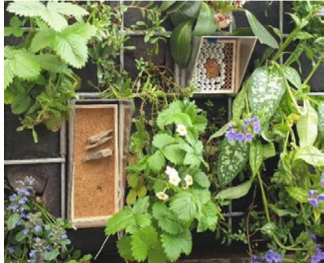
Abbildung 5: Bepflanzte Gabione mit integrierten Nistmodulen. Links: Platzhalter aus Kunststoff mit einer künstlichen Steilwand. Rechts: Platzhalter aus Aluvierkantrohr. Als Nisthilfe ist ein, mit Papierstrohalmen gefüllter, Holzrahmen eingesetzt.
