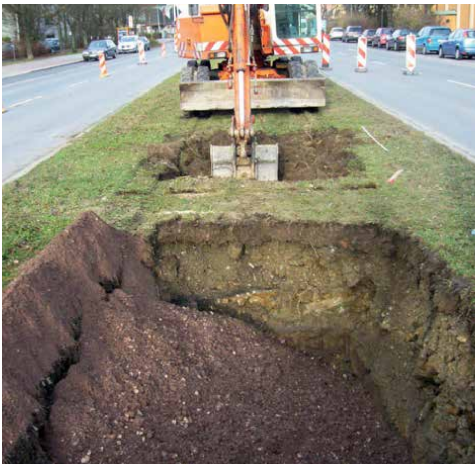
Bild 1: Die Baumsubstrate nach FLL und ZTV-Vegtra-Mü sind einschichtig aufgebaut. Das erleichtert u.a. den Einbau.
