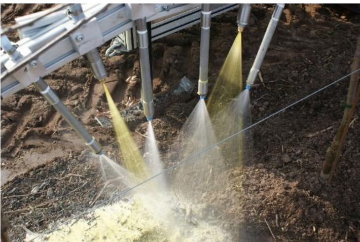
Abbildung 19: Aufspritzen des Sprühmulchs
