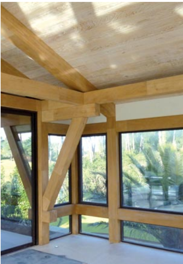
Abbildung 18: Eichenbrettschichtholz im modernen Einfamilienhausbau in Frankreich. Foto: EYF Gámiz, S.A. - © SIMONIN S.A.S.
