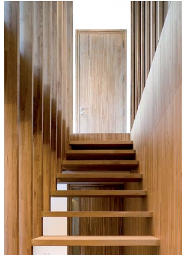
Abbildung 12: Eichenholztreppe aus Eichenleimholzplatten Foto: Elaborados y Fabricados Gámiz, S.A.
