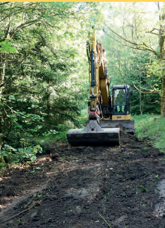
3 Planieren und Einebnen von Fahrspuren mit Kurzheck-Kettenbagger. Foto: S. Waas, LWF
