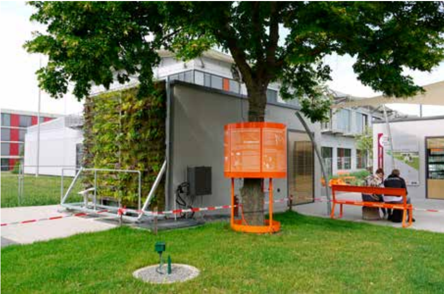
■ Bild 2: Die Klima-Forschungs-Station im Mai 2018. Zu sehen ist der nach Westen ausgerichtete Fassadenprüfstand mit beiden Begrünungssystemen sowie eine mit Messtechnik verkabelte Winterlinde
