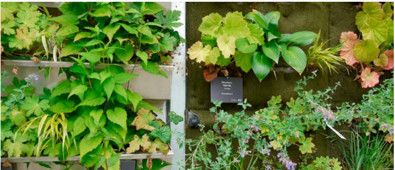
▣ Bild 1: Unterschiedliche Begrünungsstrategien: als Regalsystem mit verfüllten horizontalen Rinnen (links) oder als flächiges vlieskaschiertes substratbefülltes Vertikalsystem (rechts) (alle Fotos: LWG)
