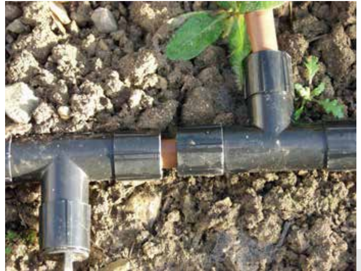
Bild 6: Easy fit Steckverbindungen für den Tropfschlauch (Rainbird). Sie sind bis zu einem Druck von 4 bar dicht.
